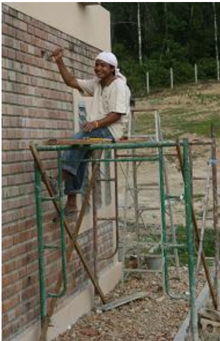
Ausbau einer Ausbildungsanlage
